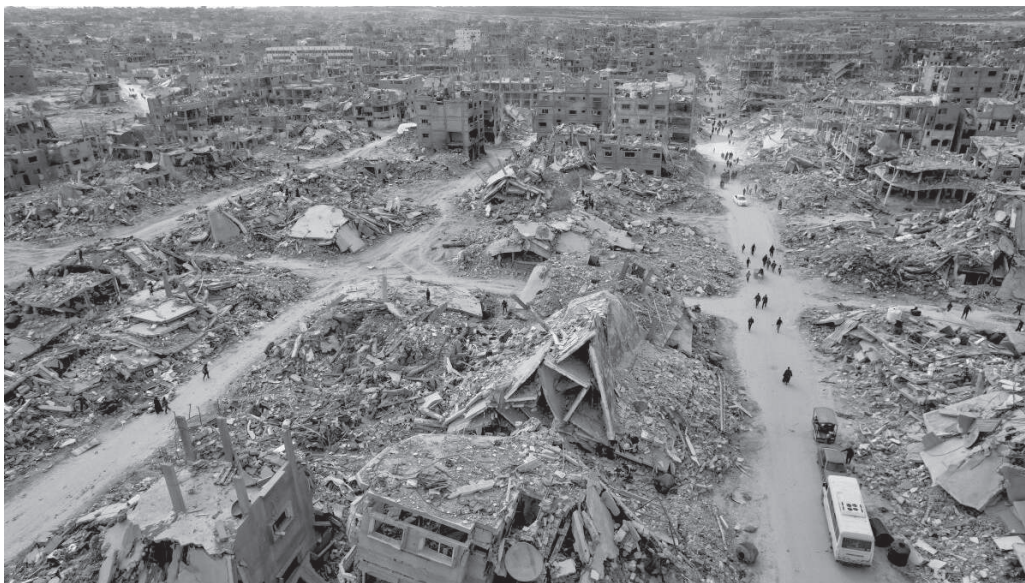
Vista aérea de la destrucción en Gaza.
